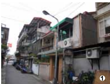
更新多為超過40年之二、三層加強磚造建物
