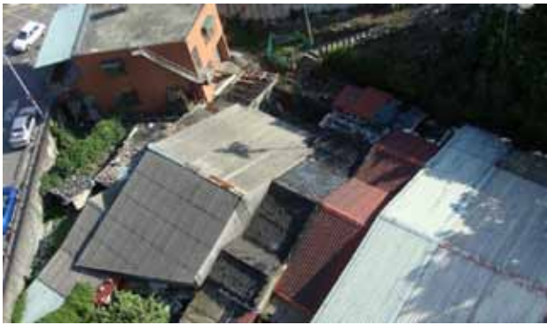
更新前僅一戶合法建物，其餘皆為違建戶
