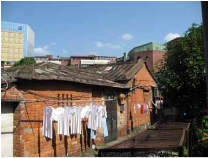
更新單元內有一整片老舊磚造房屋，舊稱為「萬寶厝」
