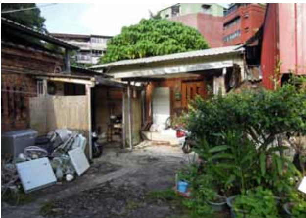
更新單元內環境窳陋且違章戶占用嚴重
